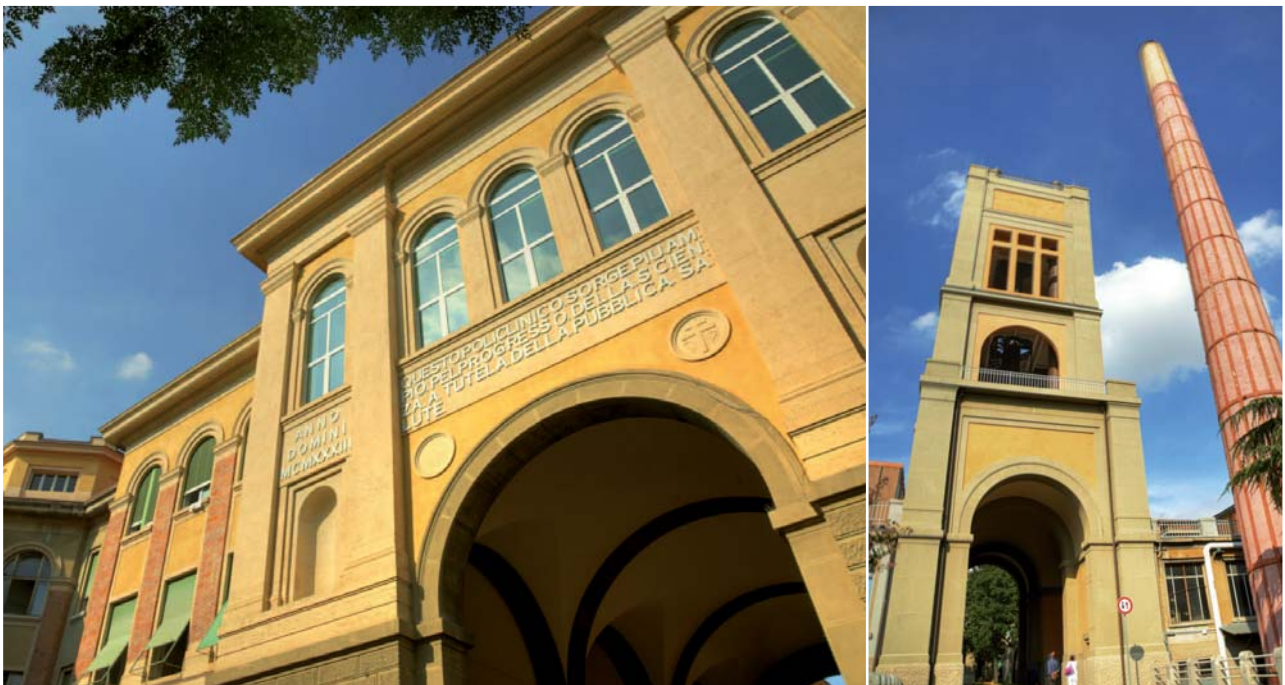
CME cura la manutenzione del complesso ospedaliero Sant'Orsola-Malpighi di Bologna CME handles the maintenance of the Sant'Orsola-Malpighi hospital complex in Bologna CME est chargé de la maintenance du complexe hospitalier Sant'Orsola-Malpighi de Bologne
