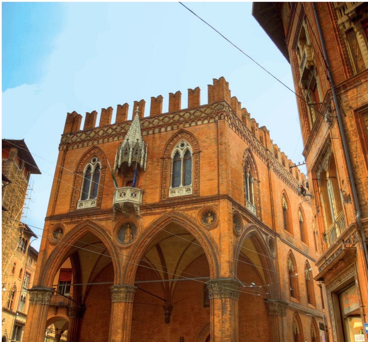
La facciata dopo il lavoro di risanamento The façade after the restoration work La façade après le travail d'assainissement
