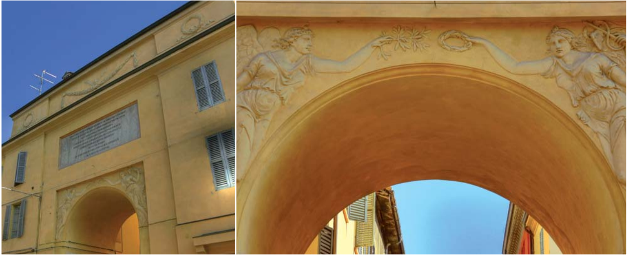
Lavoro di restauro e recupero del bassorilievo Renovation and restoration of the bas relief Travaux de restauration et remise en état du bas-relief
